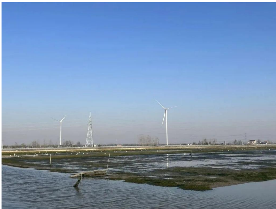
图 江苏阜宁协鑫 30MW 风电项目
